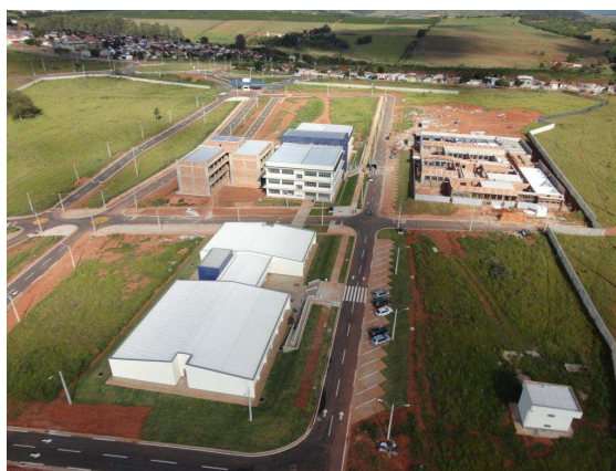
Vista geral da unidade
