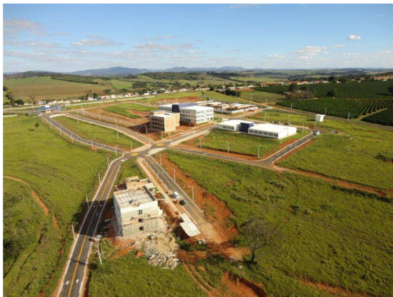
Vista geral da unidade
