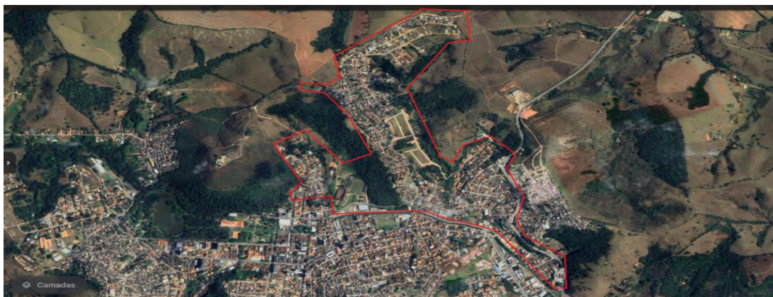
Figura 04 - Zona Residencial 2 de Caxambu
