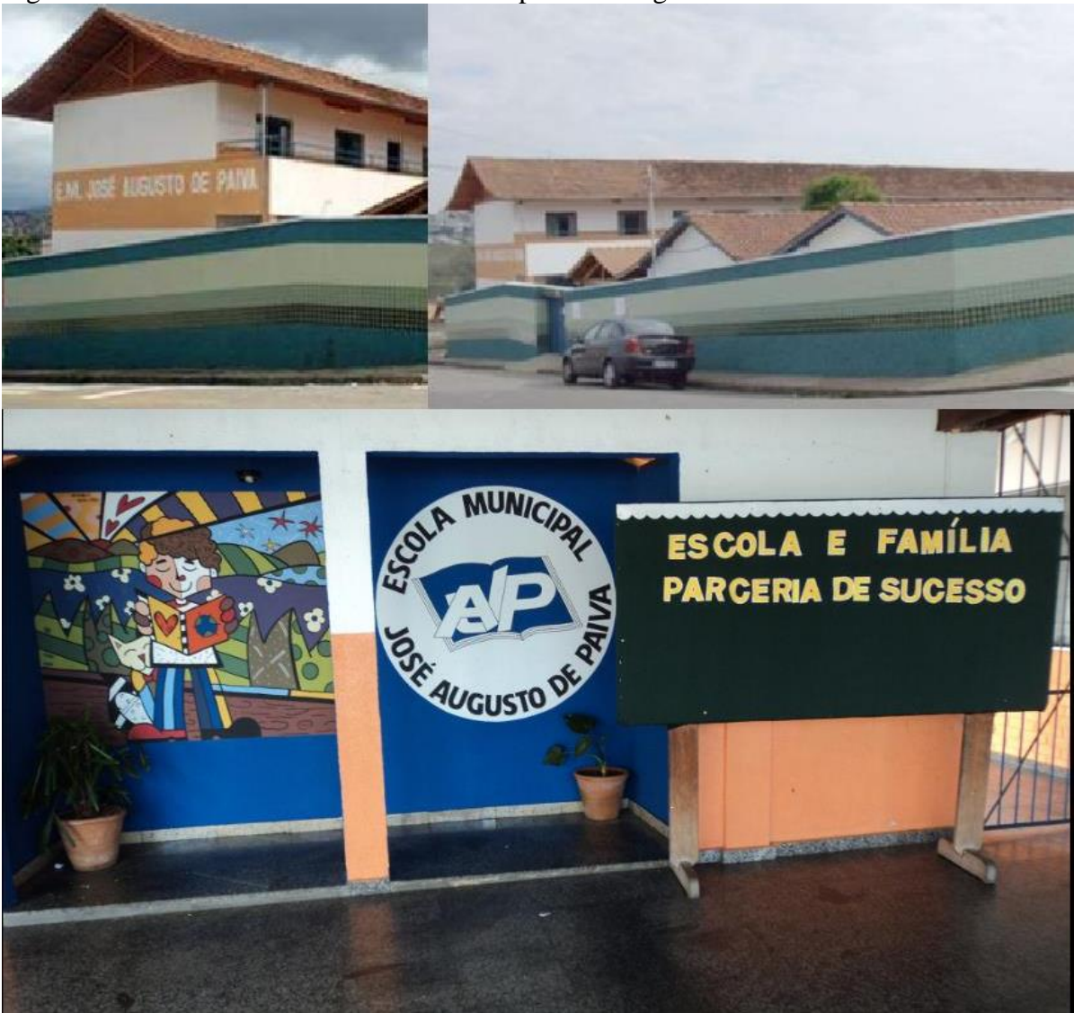
Figura 3 – Galeria de fotos da Escola Municipal José Augusto de Paiva
