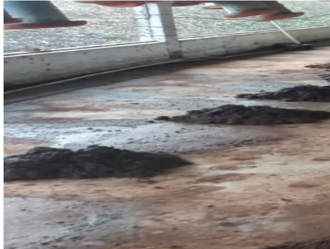
Figura 6 – Água na leira do tratamento 1, escorre pelo fundo da leira
